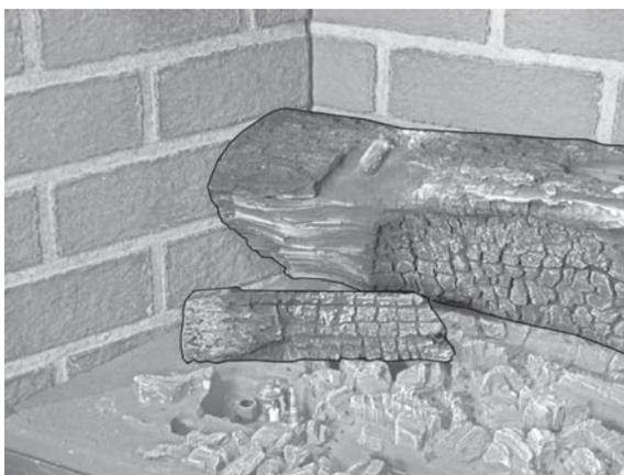
3. Placez la bûche de base gauche sur la plateforme tel qu'indiqué. Pivotez la bûche afin qu'elle ne couvre pas la veilleuse derrière et les orifices devant.
