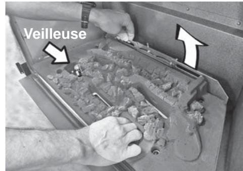
3. Pour réinstaller le brûleur, insérez-le dans la boîte de foyer en commençant par le devant. **Encore une fois, faites attention à la veilleuse en déposant le brûleur.** Fixez le brûleur au mécanisme de réglage d'aération à l'aide des 2 vis enlevées en 1.
