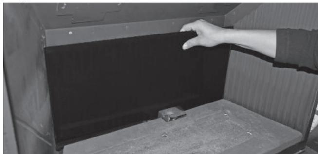
4. Insérez le bas de l'autre panneau de côté entre le brûleur et la paroi de côté, pivotez-le légèrement pour le rentrer dans la boîte de foyer. Poussez-le contre la paroi de côté. Pivotez le support d'ancrage pour tenir le panneau en place.
