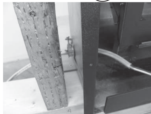
Entrée d'alimentation électrique à gauche de la caisse du foyer
