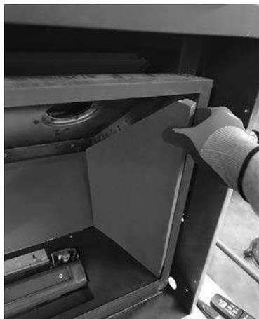
6. Insérez le panneau du haut, bord bisauté vers l'arrière, au-dessus d'un des panneaux des côtés puis centre-le de façon à ce qu'il repose sur le dessus de tous les panneaux. Glissez d'abord le panneau du haut vers l'avant si vous avez de la difficulté.
