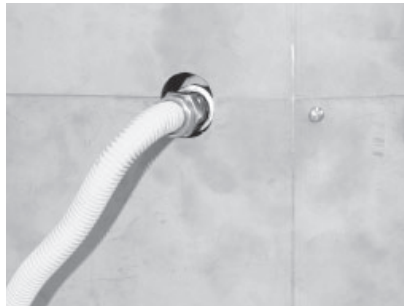
Raccord souple redirigé à l'aide d'un coude
