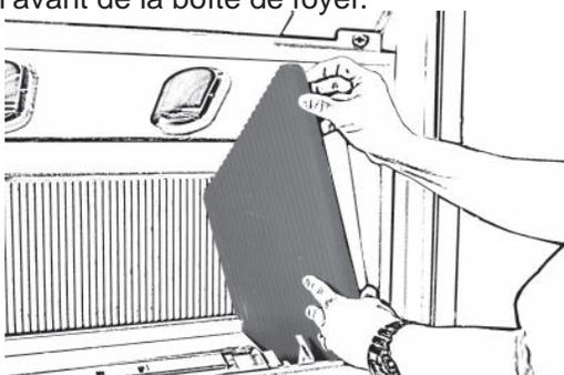
4. Insérez le panneau du haut au-dessus du panneau gauche le plus en avant possible le long de la pente de la boîte de foyer. Pivotez l'autre côté du panneau du haut et insérez-le au-dessus du panneau droit.
