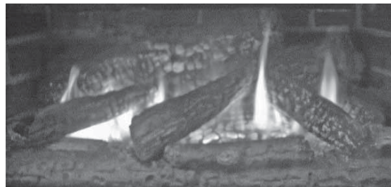
Apparence correcte des flammes
